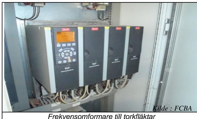
Frekvensomformare till torkfläktar
