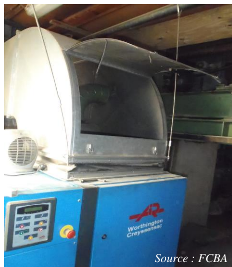
Värmeåtervinningssystem för kompressor
