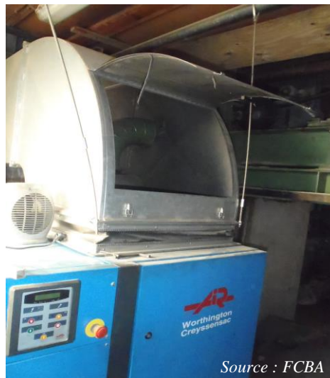
Varmegjenvinningsystem for kompressor
