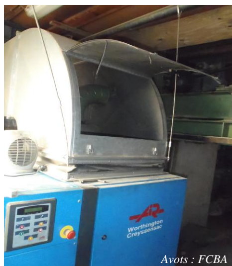
Kompresora siltuma apmaiņas sistēma
