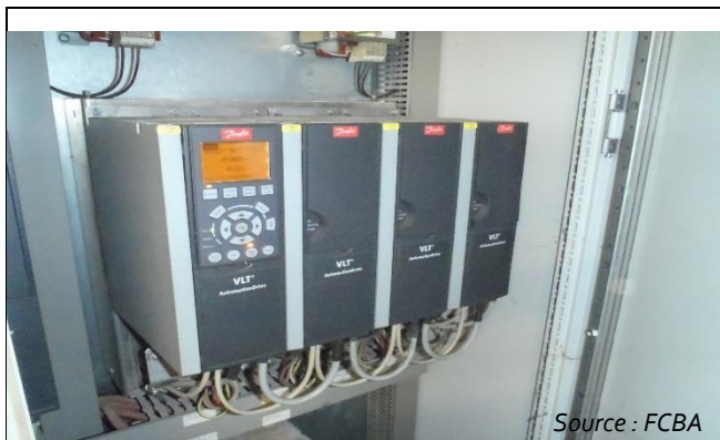
Une partie des variateurs de fréquence équipant les séchoirs
