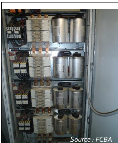
Batterie de condensateurs pour une ligne de sciage canter
